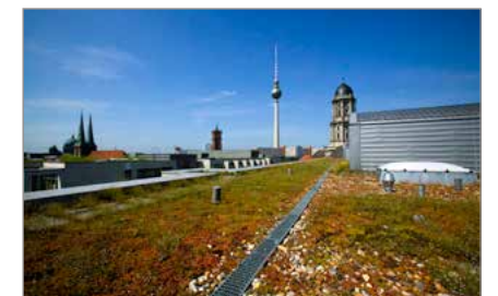
Gründach Unternehmenszentrale BWB Green roof BWB head office
