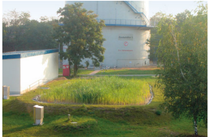
Pflanzenkläranlage für die Grauwasserreinigung Constructed Wetlands for Greywater Treatment
