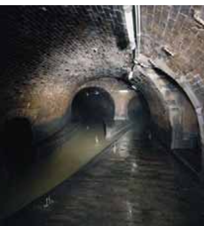
Berliner Abwasserkanal Berlin sewer
