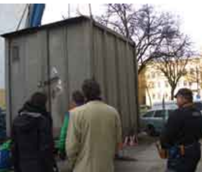
Aufstellung Messcontainer Set-up of measurement container
