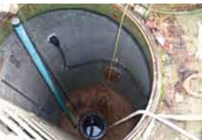
Blick in einen offenen Brunnen Open well
