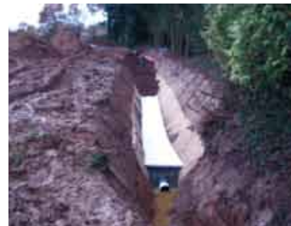
Bau einer Pilotanlage in einem Drainagegraben Construction of a pilot site in an existing drainage swale
