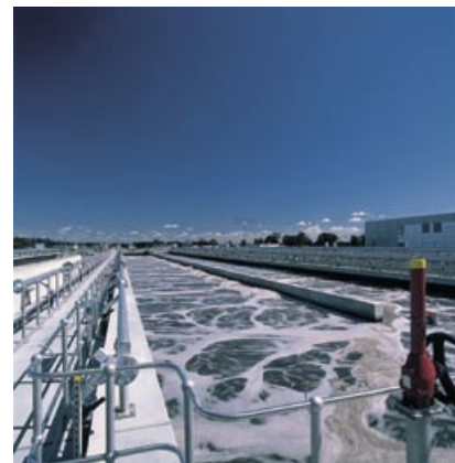
Kläranlage Wastewater treatment
