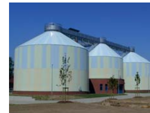
Parallele Gärreaktoren am Klärwerk Steinhof in Braunschweig / Parallel digestion reactors at WWTP Steinhof in Braunschweig
