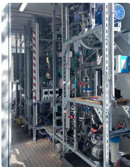
Die Anlage nach dem Umbau
