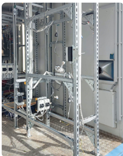
Neuaufbau des Montagegerüsts
