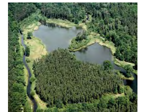
Naturnahe Grundwasseraufbereitung Berlin-Spandau Natural groundwater treatment Berlin-Spandau
