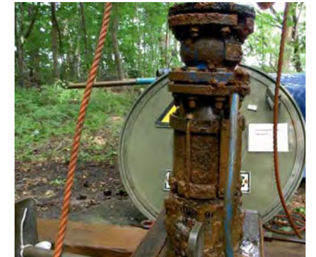
Ausbau einer verockerten Pumpe Clogged pump removed for maintenance
