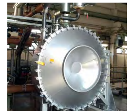
Spiralwärmetauscher zur Schlammwärmung Heat exchanger for sludge pre-heating
