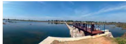
Rückhaltedamm im Monsun in einem ephemeralen Fluss / Check dam during monsoon in an ephemeral river
