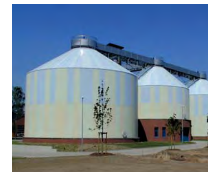
Parallele Gärreaktoren am Klärwerk Steinhof in Braunschweig / Parallel digestion reactors at WWTP Steinhof in Braunschweig
